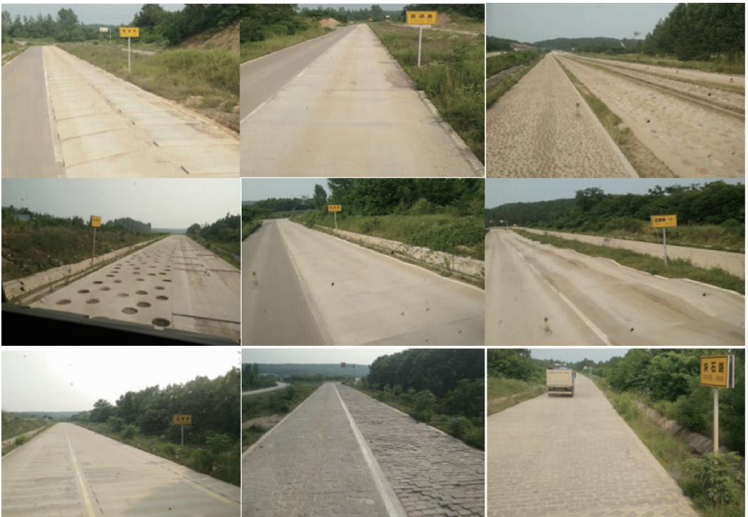
图 1 部分测试路面照片
