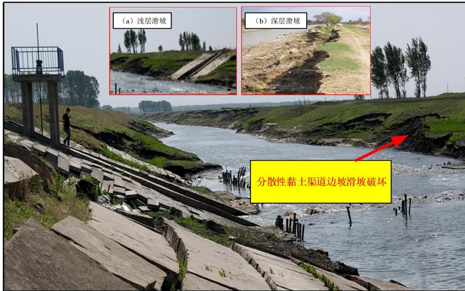
图2 东北地区分散性黏土经过冻融循环和浸泡作用后的滑坡破坏
